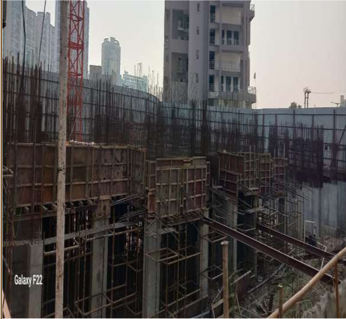
Tower 1A GF floor Pour -1 shuttering and steel wip
